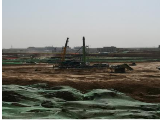
临时堆土及物料等采取的密目网苫盖措施
