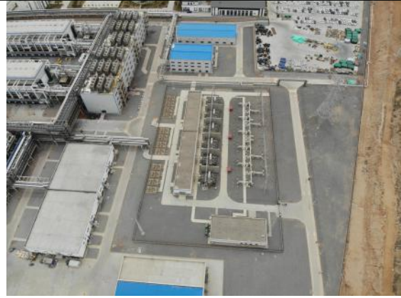
变电站全景远景
