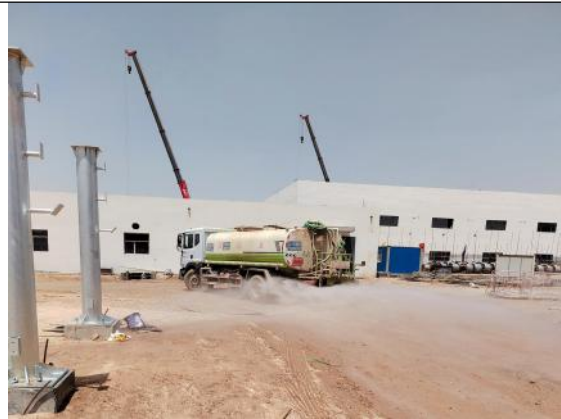
施工区域定时洒水降尘
