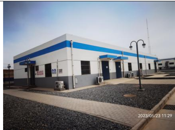
电气综合设备室
