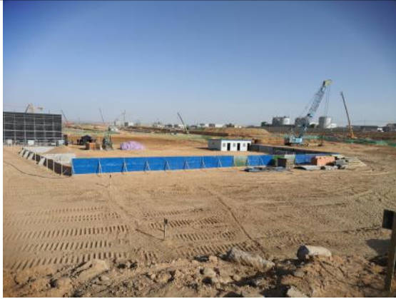
施工区域设置的施工围挡
