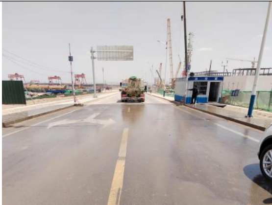
施工道路定时洒水降尘
